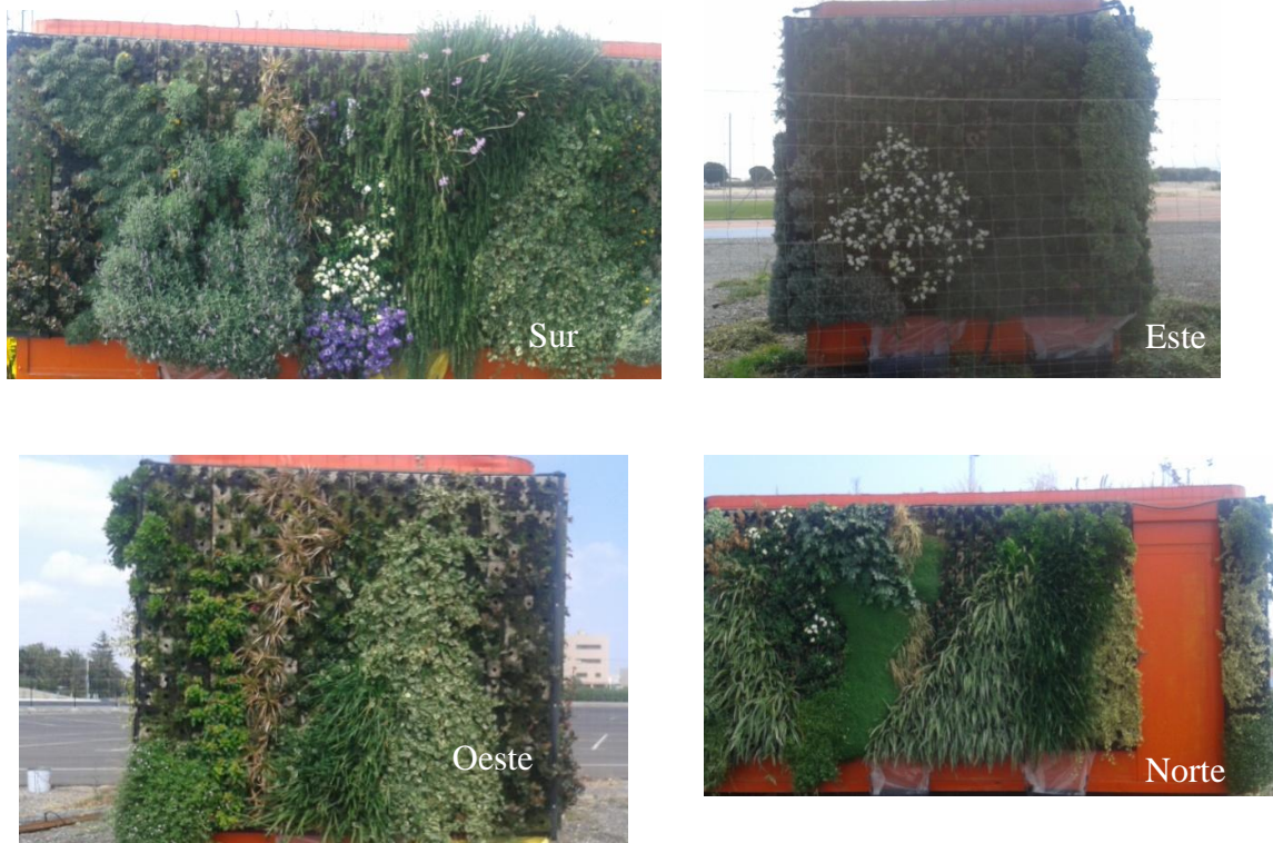
Fotografía 2. Vista de cada uno de los sistemas de jardinería vertical con módulos autoportantes Grinea® Vert 75F según orientación en la caseta.
