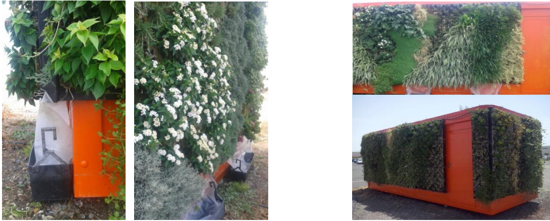
Fotografía 1. Detalle de la colocación de los depósitos para la recogida de drenajes en los módulos del jardín vertical
